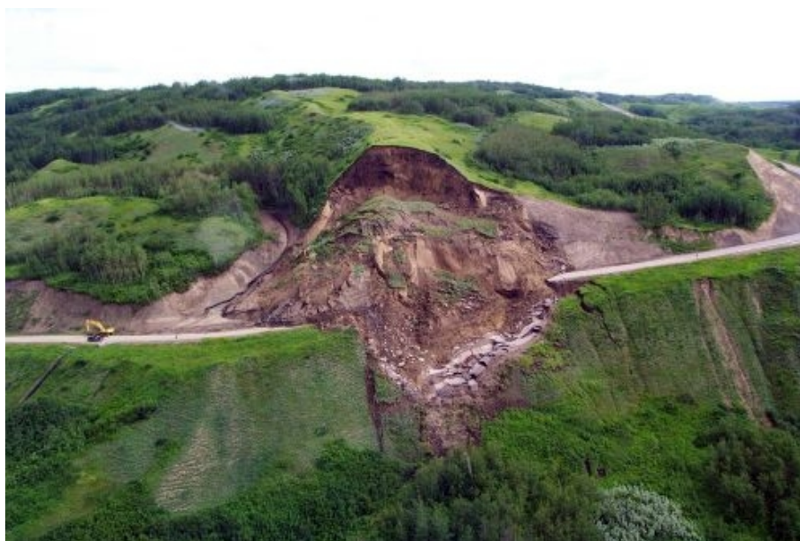
Slika 2-Prekid saobraćajnice usled klizišta
